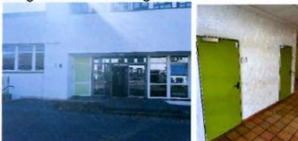
Zweite mögliche „Nottoilette“ im Gebäude B1
